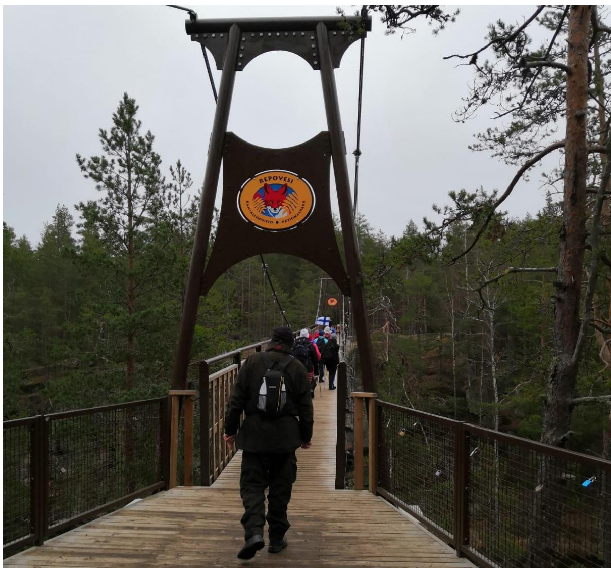
Lapinsalmen sillalla (kuva: Tuija Puustinen)
